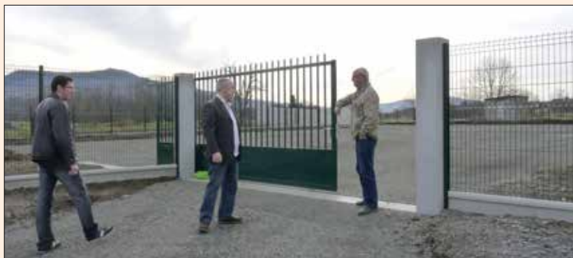
Nouvelle aire de stockage pour les services techniques : Visite avant réception des travaux par le maire, Pascal Pigot ; l'adjoint à l'urbanisme et aux travaux, Gilles Solans ; le responsable des services techniques, Florent Vivier.
